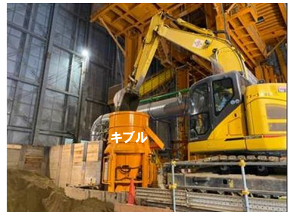
地上作業 埋め戻し材をキブル(運搬容器)へ投入 キブルを地上から立坑坑底へ槽、巻上機設備を用いて運搬
