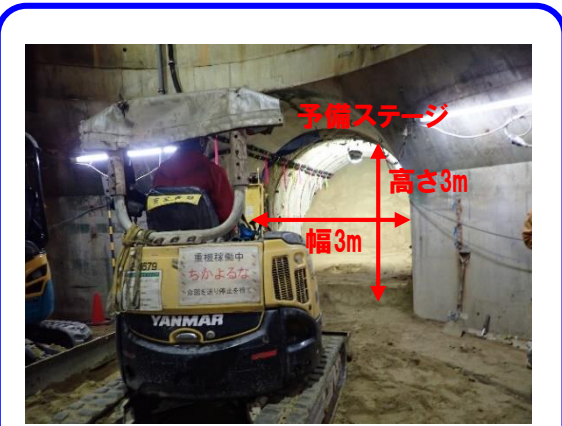
主立坑の埋め戻し作業 深度100m予備ステージ (予備ステージ：幅3m、高さ3m) (主立坑：直径6.5m)
