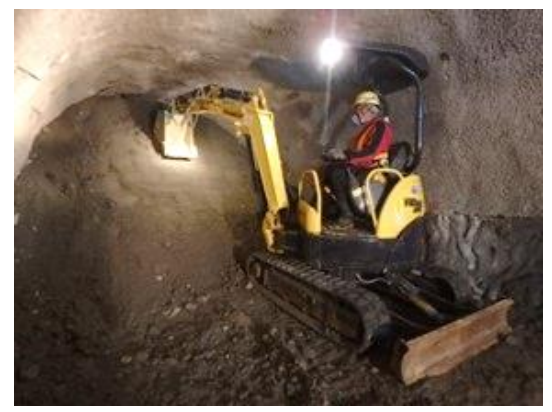
水平坑道の埋め戻し作業 深度500m研究アクセス南坑道 写真の坑道規模：幅4m、高さ3.5m
